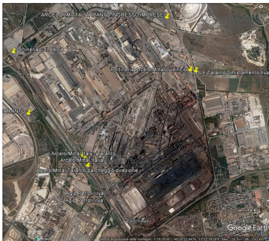
Stabilimento siderurgico ciclo integrale di Taranto (Arcelor-Mittal)
